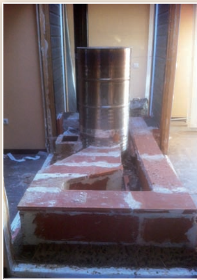
Los dos modelos de quemadores rocket: el de carga vertical a la derecha y el modelo batch-box a la izquierda.
